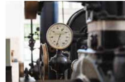
20 Kraftwerk am Proviantbach
