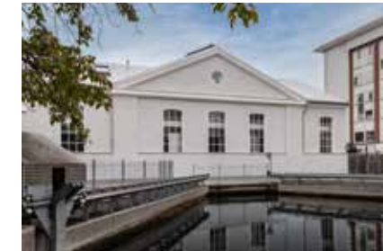
17 Kraftwerk am Senkelbach
