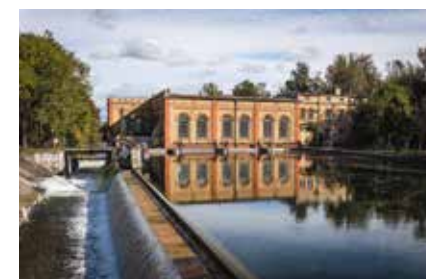
15 Kraftwerk an der Wolfzahnau
