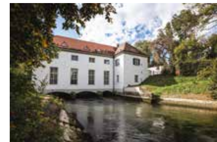
19 Kraftwerk am Wertach-Kanal
