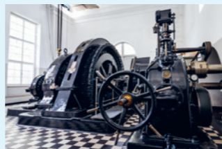
Kraftwerk am Wertachkanal 19
