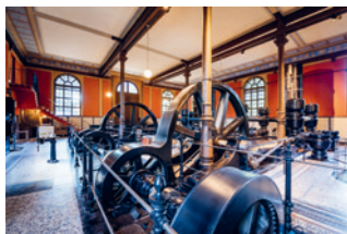
Wasserwerk am Hochablass 11
