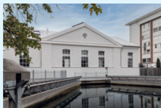
Kraftwerk am Senkelbach 17
